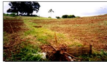
4. Paglilagay ng suplementong istrakturang gawa sa kawayan upang maiwasan ang paglaki ng kanal na sanhi ng malakas na agos ng tubig-ulan sa ibabaw ng lupa.
